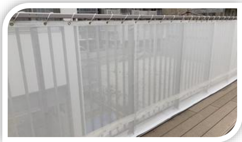
2階園庭の手すりにシートを貼りました
