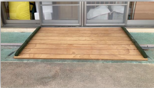
大きくて頑丈なスロープが完成！
