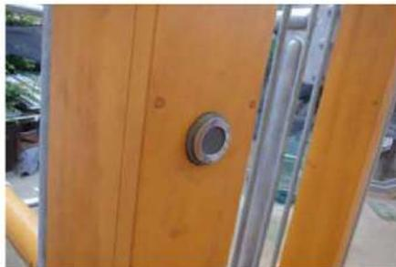
↑伝声管 ここで声を出すと、下で声が聞こえます(逆もできます)。水道のパイプを組み込んだ簡単な仕組みですが、子どもの興味を引く仕掛けになっています。
